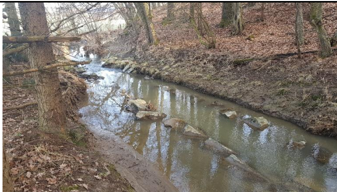
Uferverbau funktionslos
