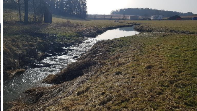
Umgehungsgerinne nicht durchgängig (Schnarmühle)
