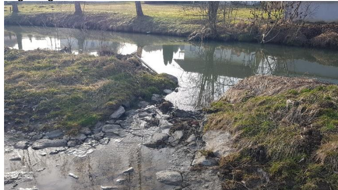
Umgehungsgerinne nicht durchgängig (Diepoltskirchen)
