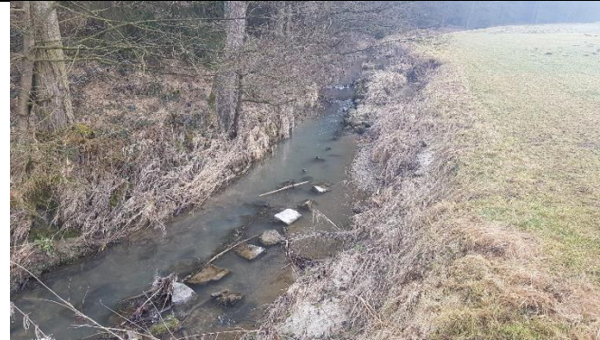
Uferverbau funktionslos
